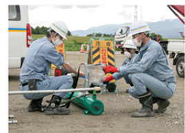
②ガスが漏れていないかの 確認
