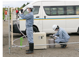
③お客さま宅の応急的なガス 復旧作業
