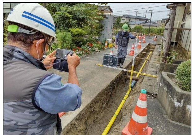
工事現場でアプリ操作している様子
